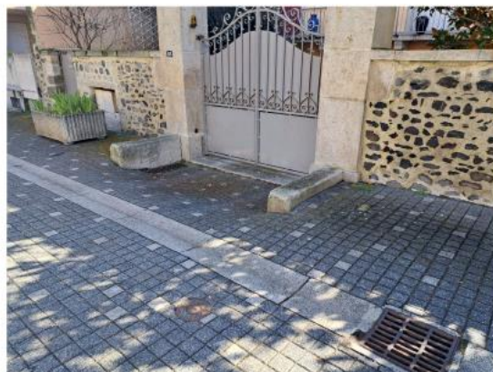
Entrée basse avec murets de soutènement
