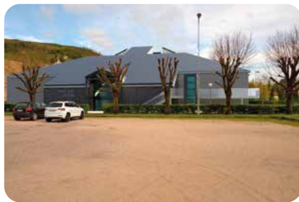
Projection du bâtiment rénové
