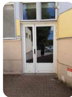
Remplacement de la porte de la salle communale « Dourieux »
