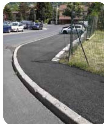
Réfection du trottoir de la rue des artisans
