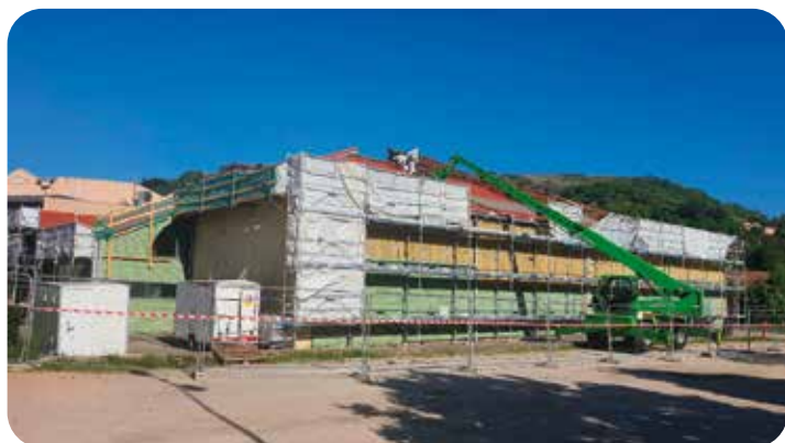
Les travaux de rénovation du tennis club ont débuté
