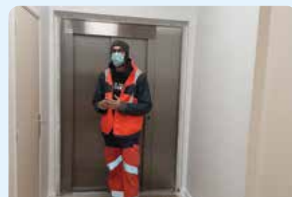
Installation d'un ascenseur
