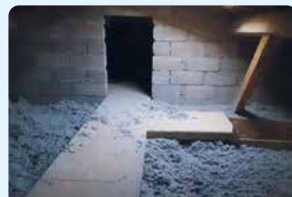
Isolation des combles
